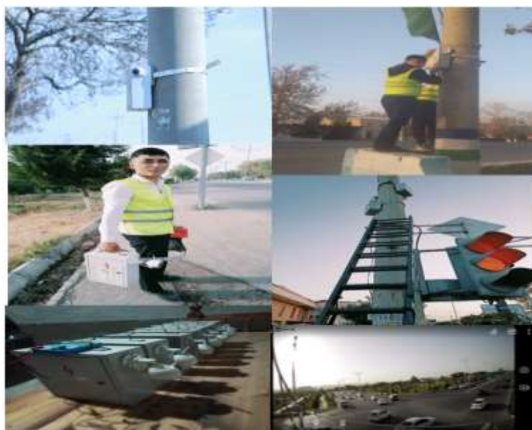
3-rasm Jizzax shahar markaziy chorrahalarida video kuzatuv kameralarini oʻrnatish jarayoni
