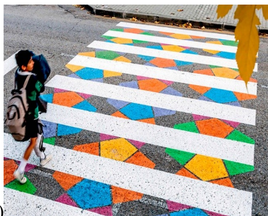
1.3-rasm. Oddiy asfalt yuzani bo‘yash orqali rangli qoplama hosil qilingan a) piyodalar o‘tish joyi b) velosiped yo‘li [7].
