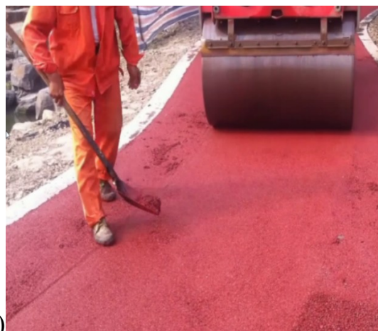
1.2-rasm. Shaffof polimer bog‘lovchilar a) epoksid smola asosidagi b) kompleks polimer bog‘lovchi asosidagi rangli asfalt-betonlar [6].
