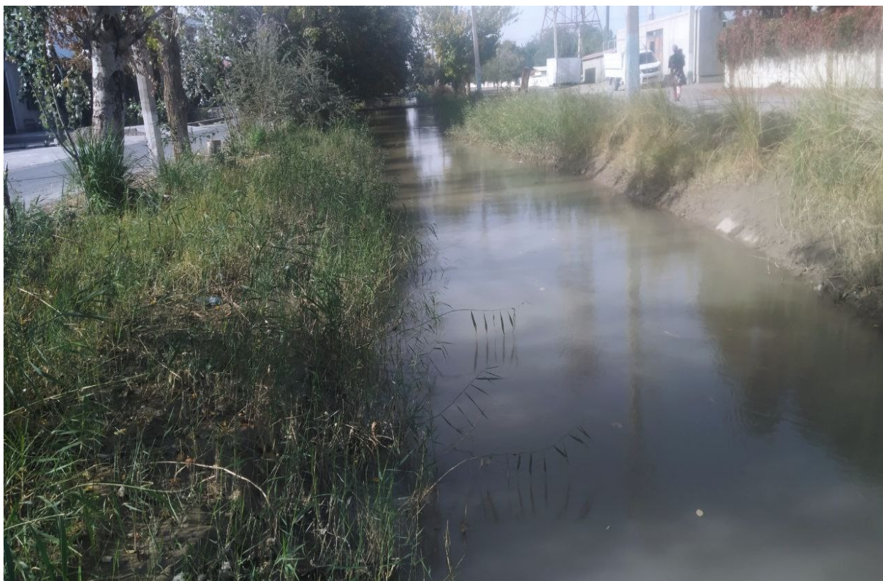
1-rasm Chorbakir kanali PK40+00
