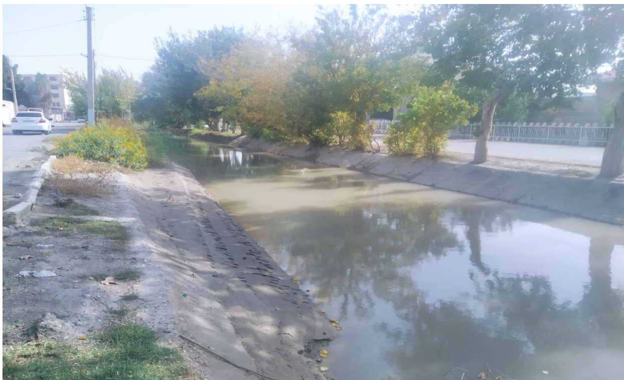
2-rasm. Chorbakir kanali PK45+00
