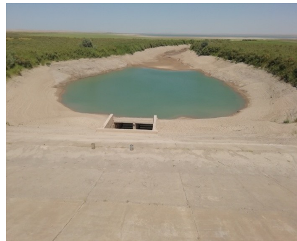
3-rasm. Suv omboriga 7-nasos stansiyasidan suv tashlash inshooti kanali koʻrinishi.
