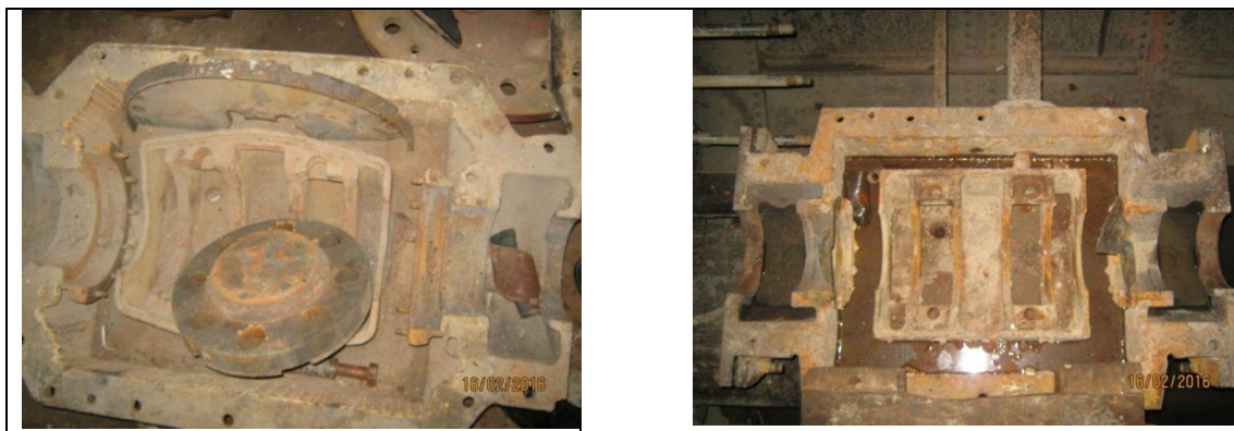
Рис. 2 Внутренняя поверхность рабочей камеры (котла) гидротурбины
