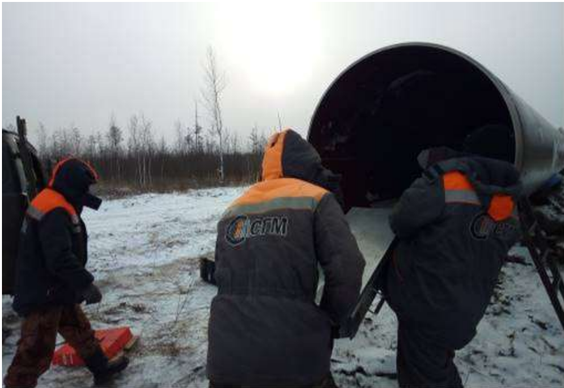
Рис. 4. Установка кроулера в трубу.
