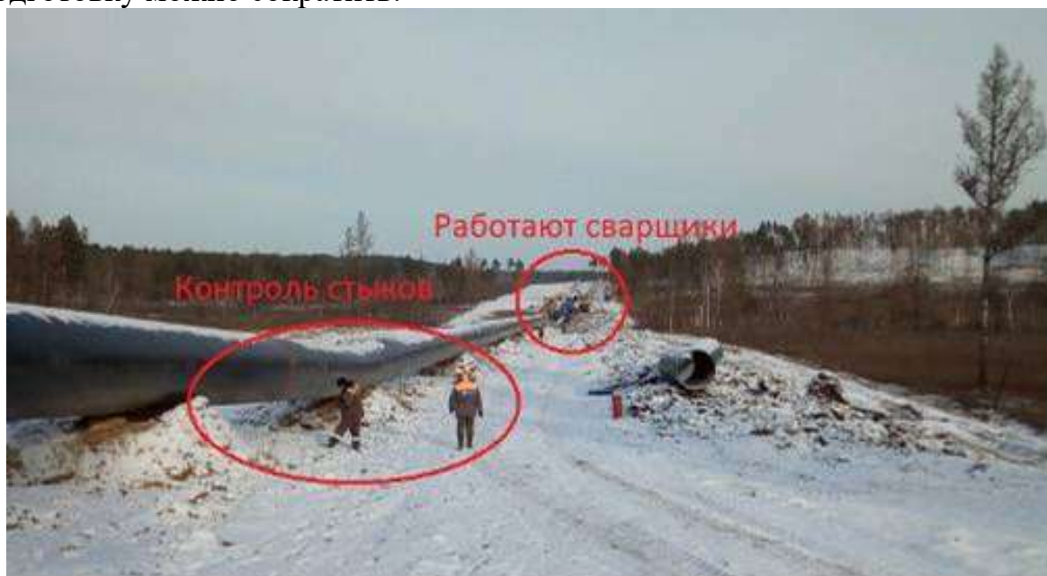
Рис.5 Расположение сварочной колонны и бригады ПИЛ на трассе.
