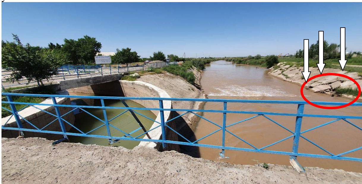
1-rasm Gidrouzel beton qoplamasini buzilish holatlari
