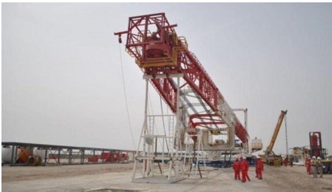
1 – rasm. Minorani demontaj qilish.
