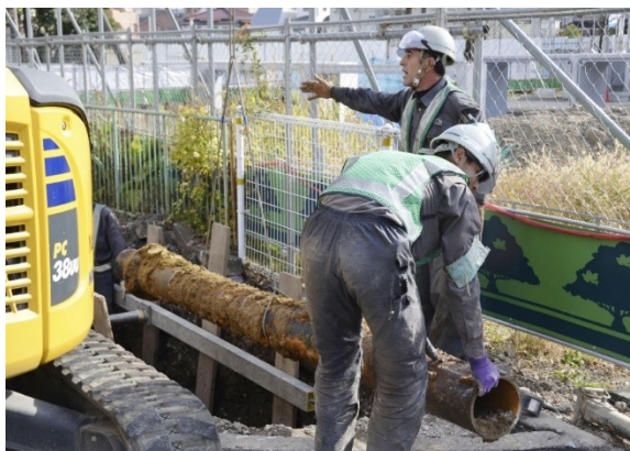
3-rasm. Eskirgan suv ta'minoti tarmog'idagi quvurni almashtirish jarayoni Yer osti suv quvurlarini buzilishi va korroziyasini oldini olish va kamaytirish strategiyalari
