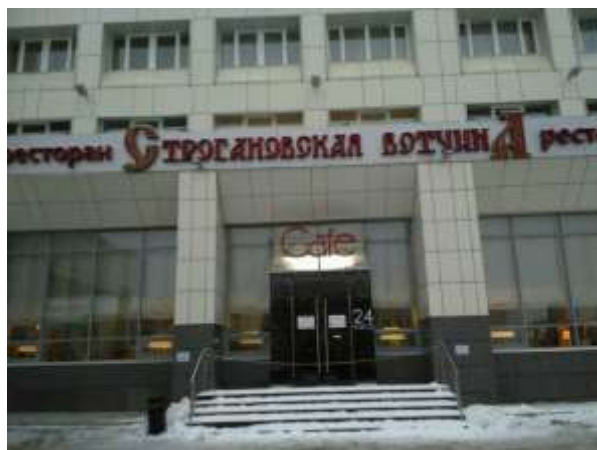
Рисунок 1 - вход в ресторан ООО «Строгановская вотчина»
