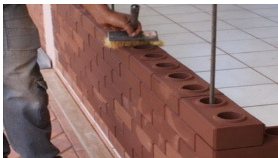
Рис.1.Укладка «ЛЕГО» кирпича
