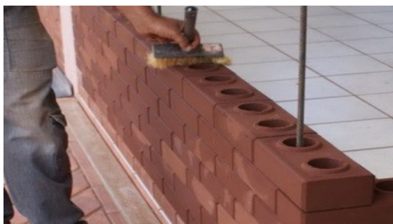
Рис.1. Укладка «ЛЕГО» кирпича Рис.2. Элементы «ЛЕГО» кирпича
