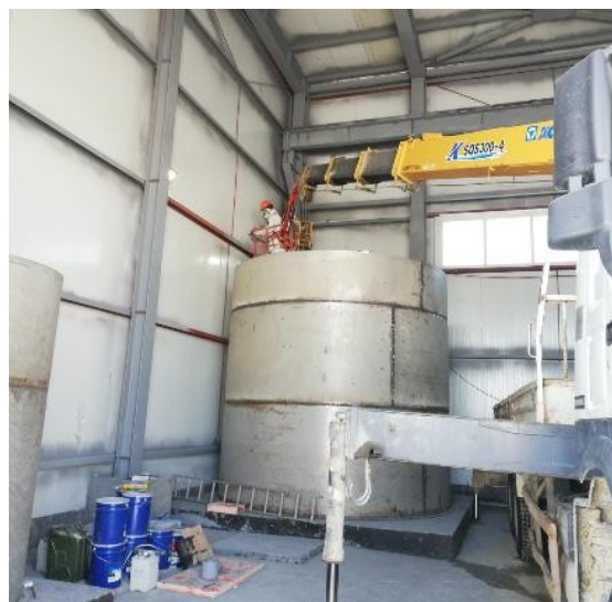
Рис.11 Инокуляция. Расширение насосной станции рафината для размещения питательного (ТК-100) и семенного (ТК-300) баков с насосами, а также склада хранения питательных веществ.
