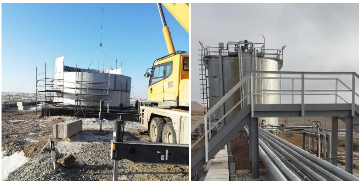
Рис.13 Инокуляция. Строительство ТК-200 – резервуара инокулята, в котором происходит смешивание начального инокулята, питательных веществ и рафината для роста бактерий.
