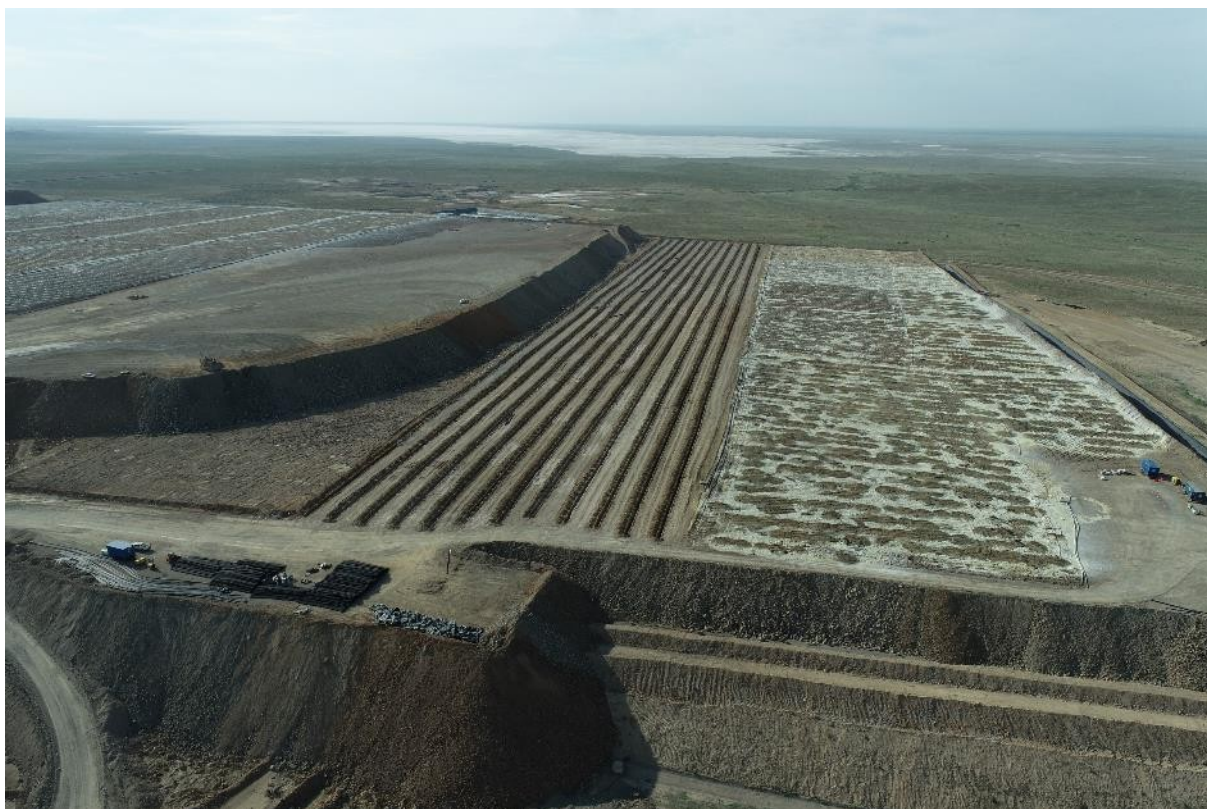
Рис.8 ПКВ-2. Укладка стрингерных труб системы принудительной аэрации
