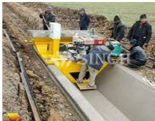
1-rasm. Kanallarni betonlashtirish jarayoni.
