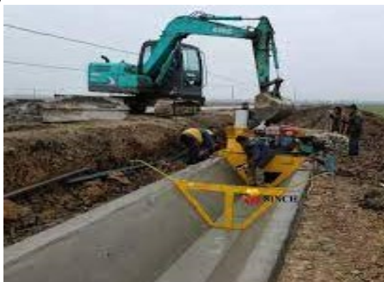
1-rasm. Kanallarni betonlashtirish jarayoni.
