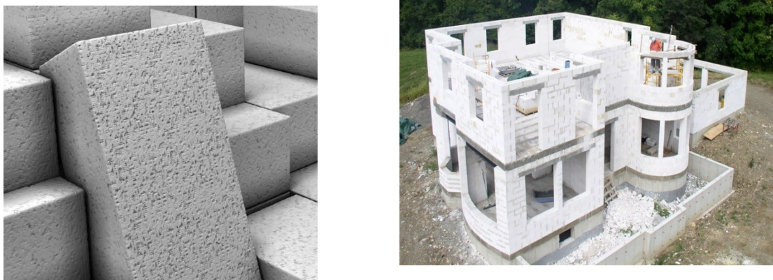
Рис.1. Внешний вид газобетона и здание, выполненное из газобетонных блоков.
