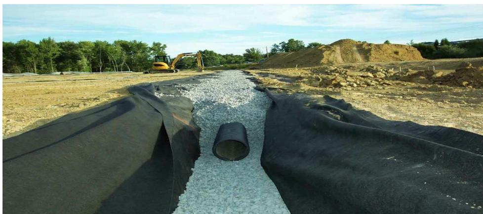
Рис.8. Закрытые дренажные трубы (перфорированные)
