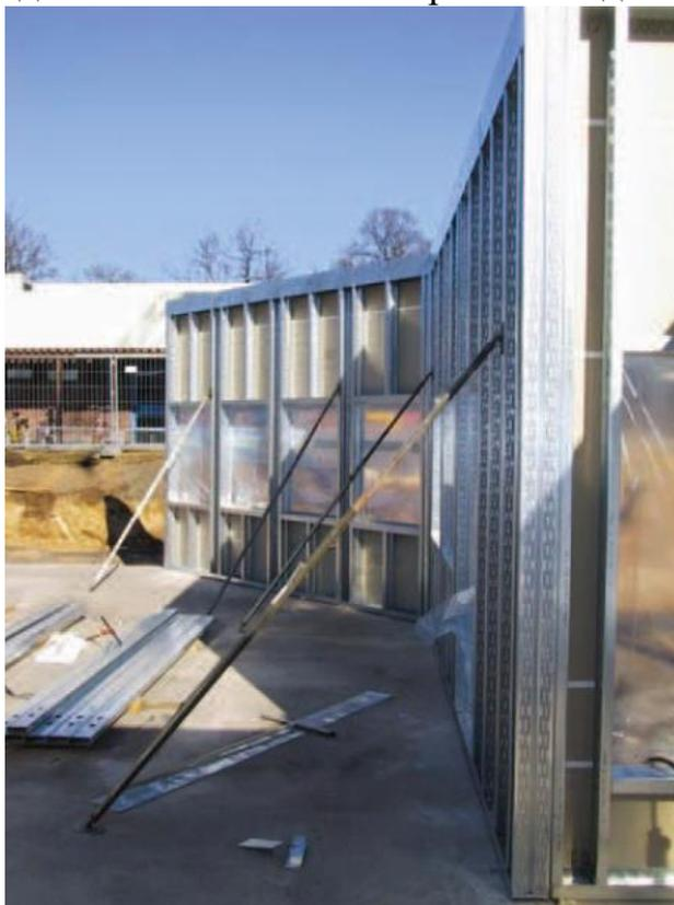
Рис. 1. Полносборные фасадные элементы в процессе строительства
