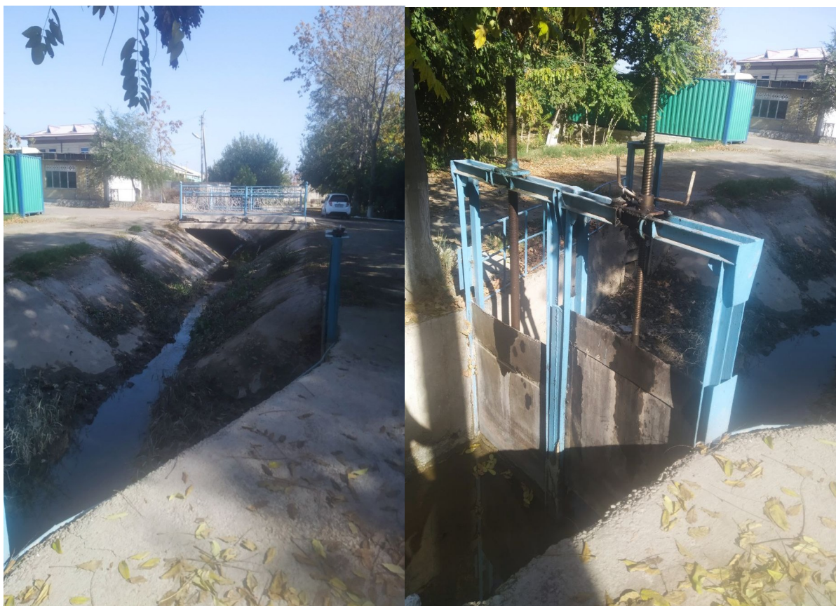
1-rasm. Shoxrud kanali PK14+77 dan PK18+00 gacha
