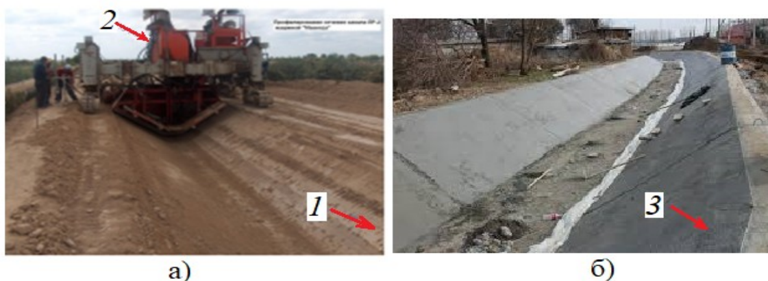
2-rasm. Kanal o‘zanini betonlashga tayyorlash.
