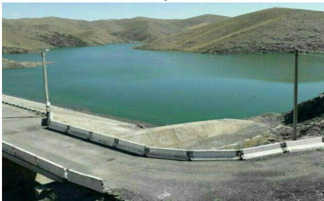
Рисунок 1. Вид на недавно построенное водохранилище Абдуллаханбанди
