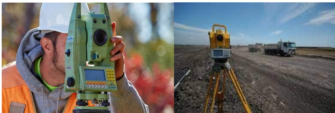
Рис.2 Процесс измерения электронным тахеометром
