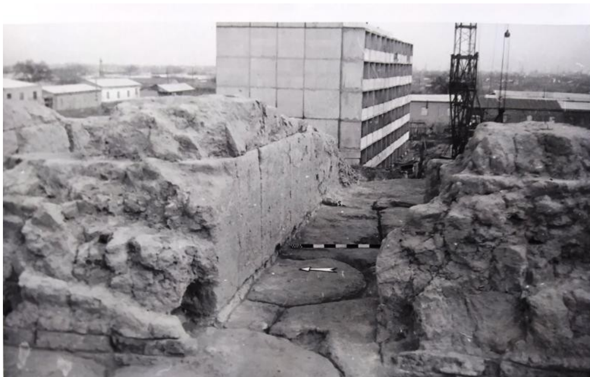
Фото.6. Вид антисейсмического слоя под стенами (с научного архива АИ АН УзССР).
