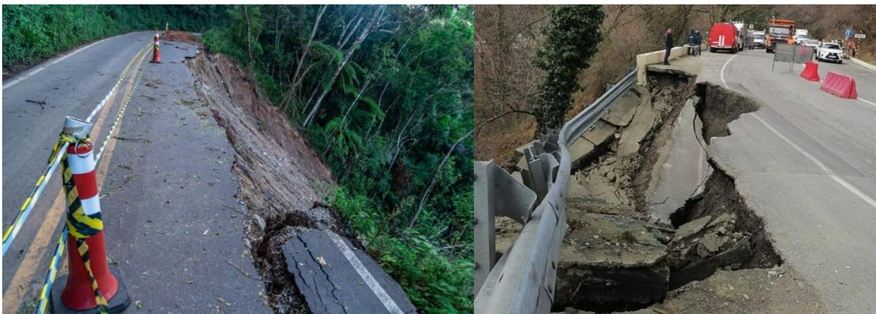
**Рисунок-2. Оползания откосов насыпи автомобильной дороги.**
