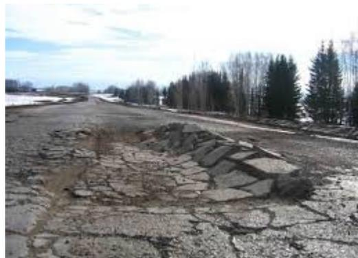
**Рисунок-1. Пучинообразования на автомобильных дорогах**
